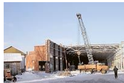
Строящийся производственный комплекс
